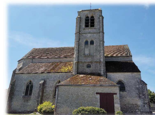
Figure 37 : Eglise Saint-Martin d'Auxy (Crédit photo : NCA Environnement, mai 2020)
